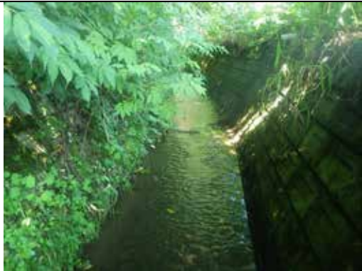
河川（栴沢・押口沢） 撮影：平成 29 年 8 月 2 日
