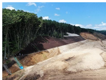
法面の植生基材吹付け状況 (施工中)
