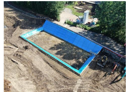
仮沈砂池設置完了
