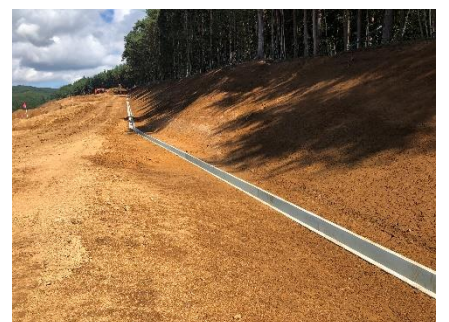
法面の小段排水設置状況 (施工中)
