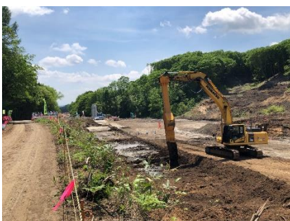
地盤改良状況(施工中)
