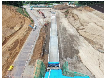
防災調整池工(施工中)
